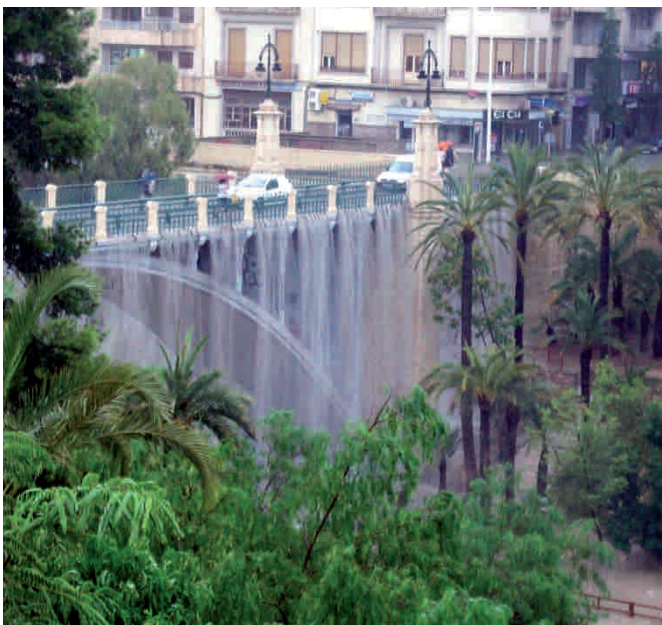
Inundación en el puente Canalejas. Elx (Alicante) 2009.
