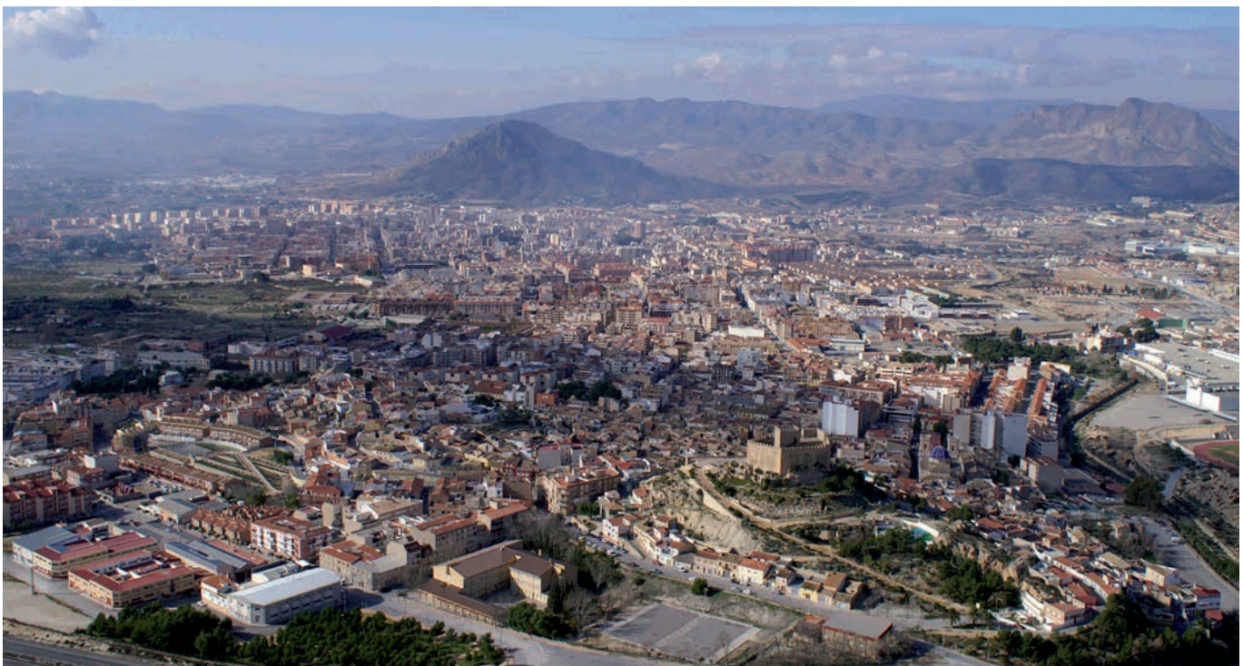
Conurbanización en el eje del Vinalopó.
