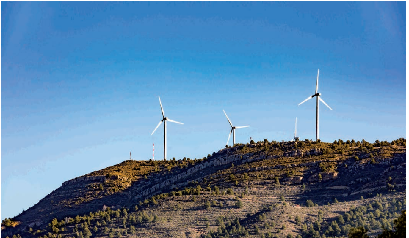
Aerogeneradores en Aras de los Olmos.
