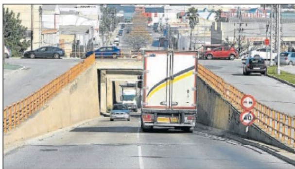
Paso inferior de Villa de Bilbao, que conecta las dos fases de Fuente del Jarro. PEDRALES BORDA
